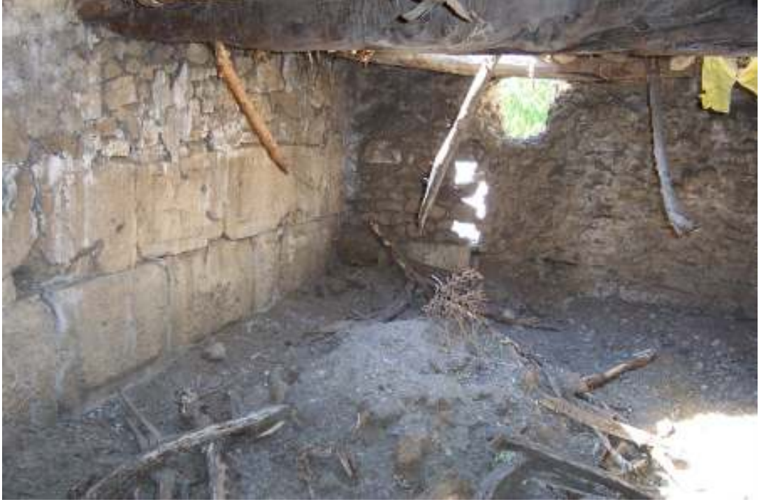
a. Şar Köy Tiyatro, Scene İç Duvarlar. (K.S. Girginer).
