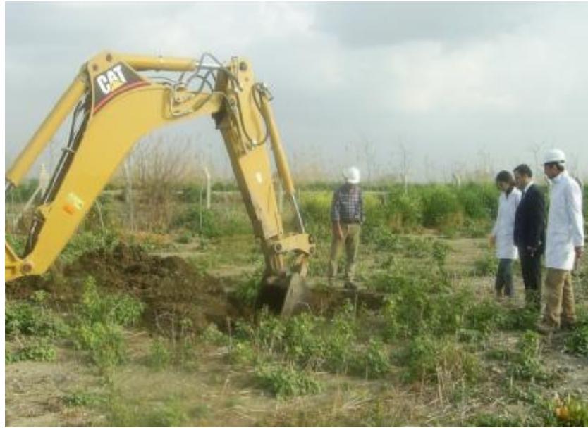
Şekil 3.2. Arazide Muayene Çukuru Açılması
