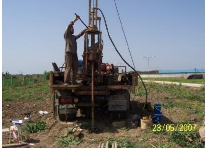
Şekil 3.3. Arazide Sondaj Kuyusu Açılması
