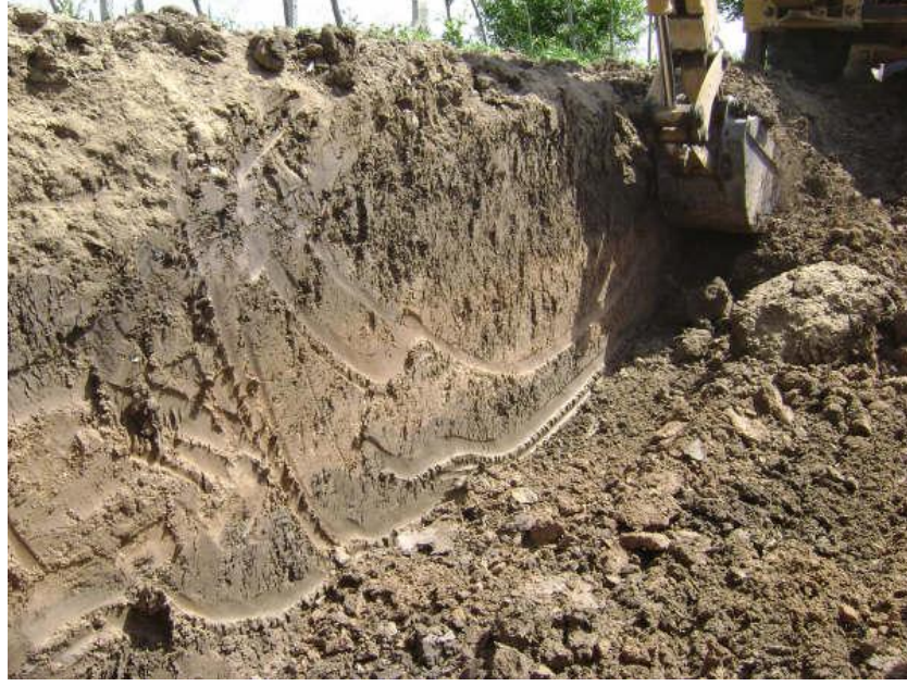
Şekil 3.35. Çalışma Alanının JCB ile Açılması
