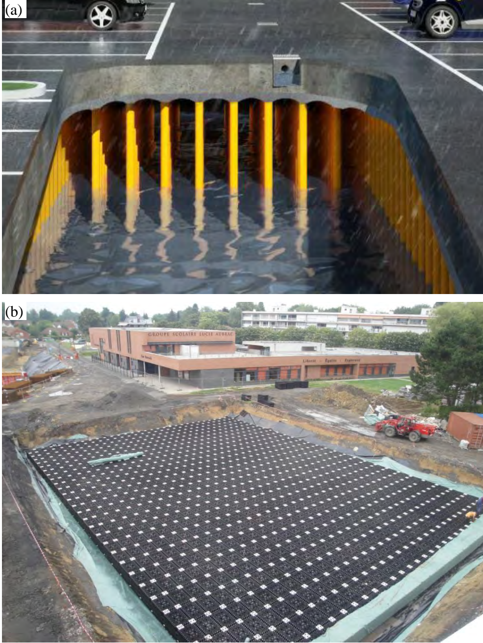
Şekil 3.16. Modüler sistem depolama havuzu örneği, a) Kesit görünüşü, b) Üst görünüşü ( https://pascoe-ltd.co.uk )
